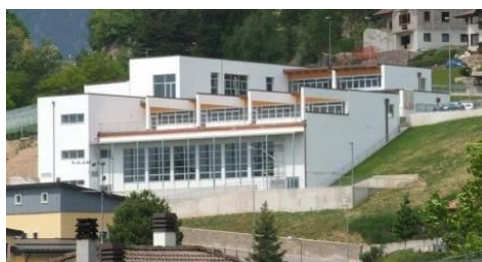
Revò – Scuola elementare
