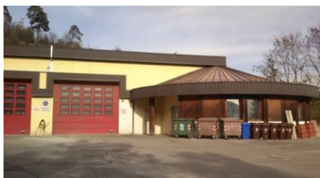
Campodenno – Magazzino e sede Vigili del Fuoco VVF
