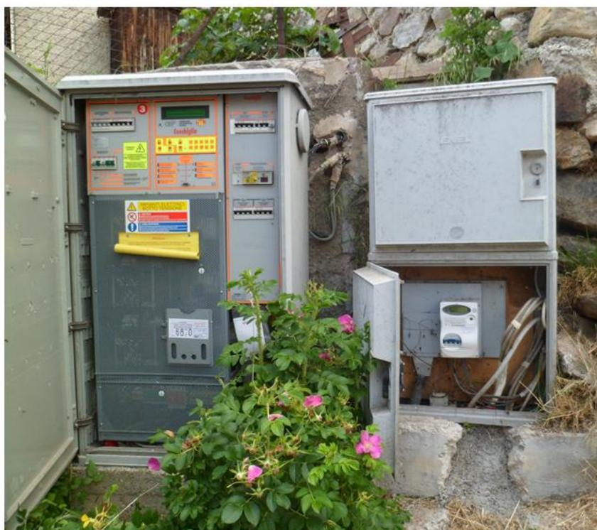
*Fig. 17 – Il quadro installato in località Mione*
